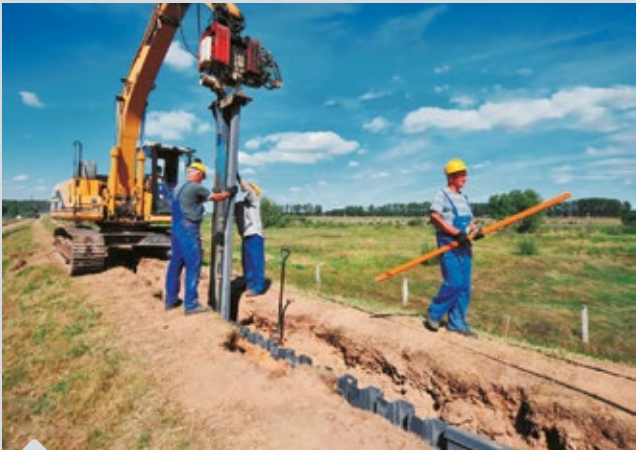
Waterdicht maken van dijk tegen overstromingen.
